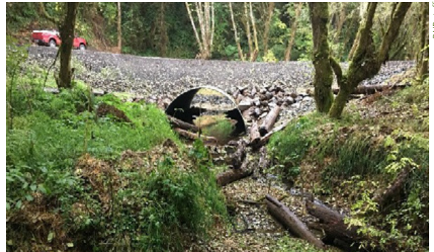
Photo 1. Fish passage culvert.
